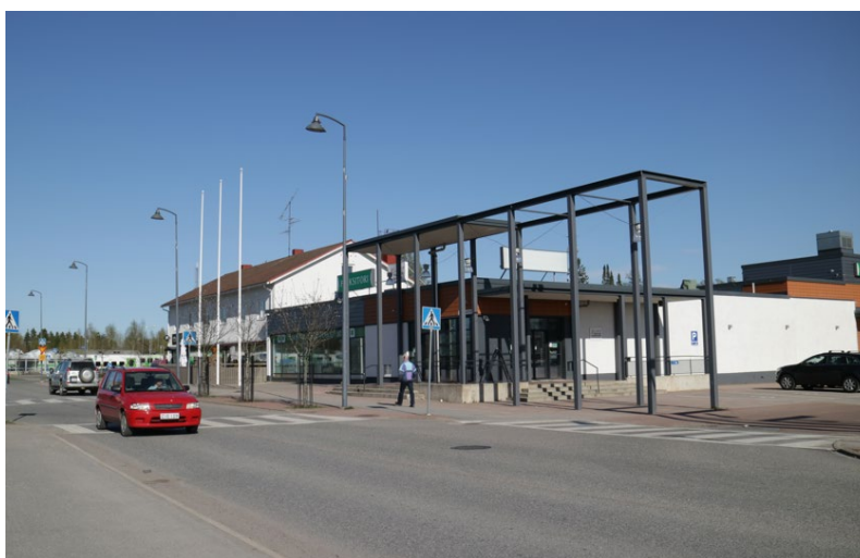
Valokuva kaavamuutosalueelta. Vasemmalla E-osuusliikkeen talo ja oikealla uudempi liikerakennus. © Tuusulan kunta
